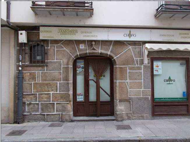
Calle Mayor, Plaza España y casa en calle Mayor nº 8 con inscripción árabe en la parte superior del arco
