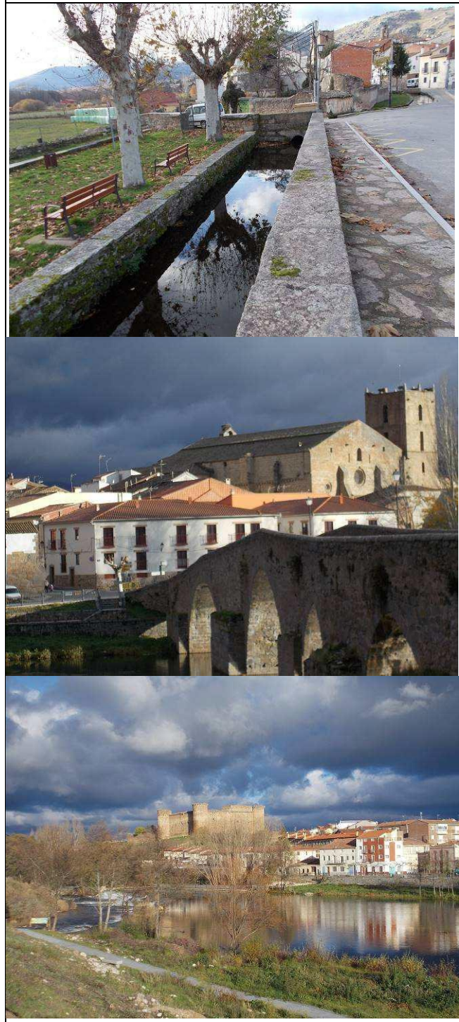
Muralla en la zona de la Reguera, entorno de la iglesia de la Asunción, puente y vista del castillo
